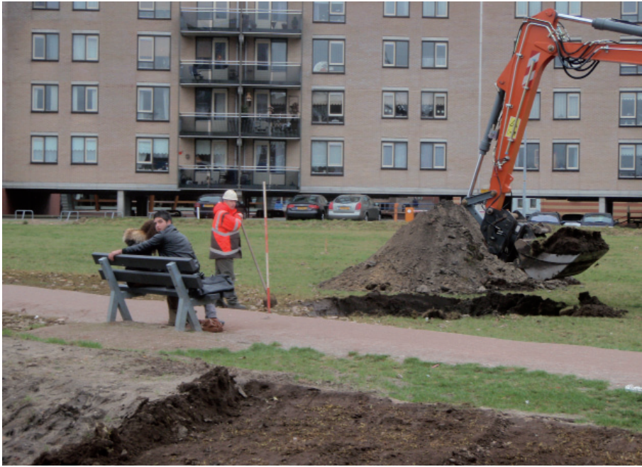
Afb. 2.02 De graafwerkzaamheden werden zo publieksgericht mogelijk uitgevoerd.
